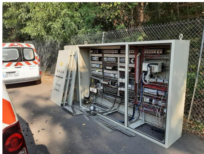
Ancienne armoire électrique STEP Jassans
