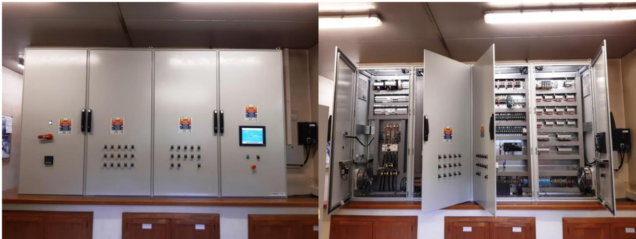
Nouvelle armoire électrique STEP Jassans
